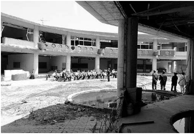
被災した大川小学校の校舎 2階の天井まで津波が襲った
