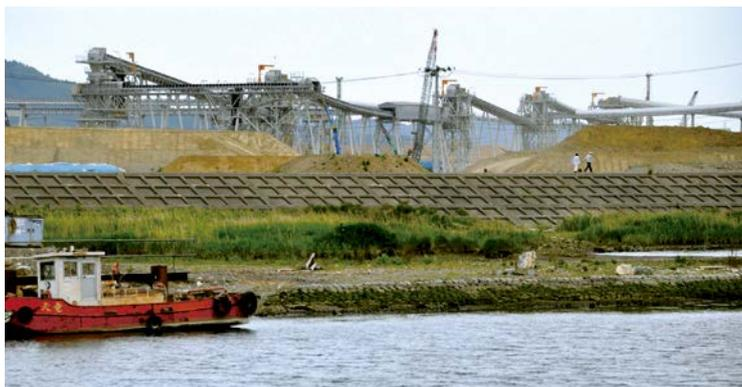
街全体をかさ上げするため、周囲の山を削り巨大なベルトコンベアで土が運ばれている。(岩手県陸前高田市)
